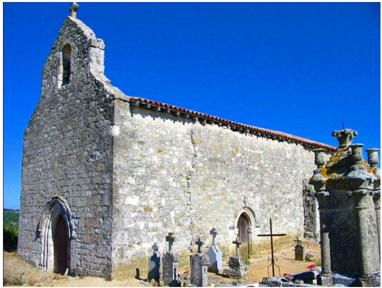
Eglise de Rides (47) (la porte des Cagots est sur le côté de l'église)
