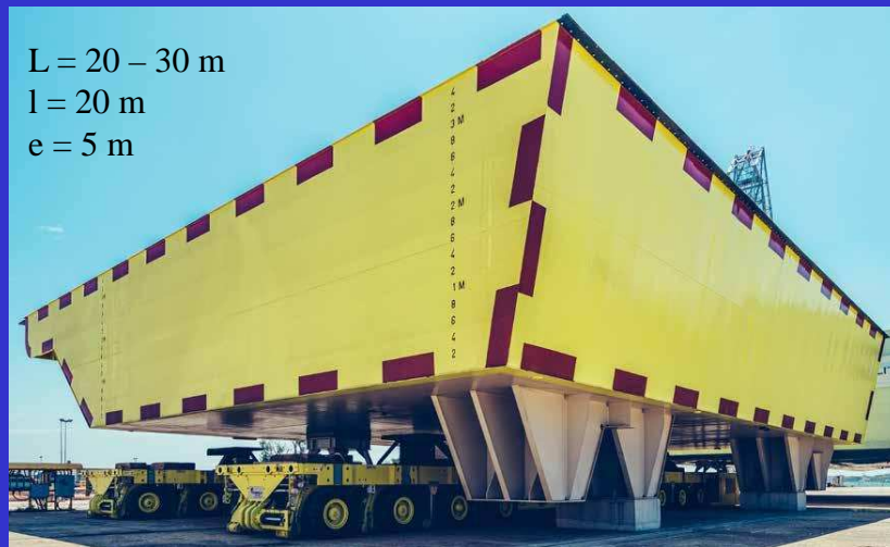
Caisson : Sortie d'usine - déplacement sur terre
