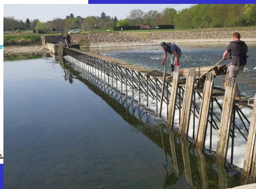
Barrage à aiguilles
