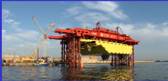
Caisson suspendu à la plateforme
